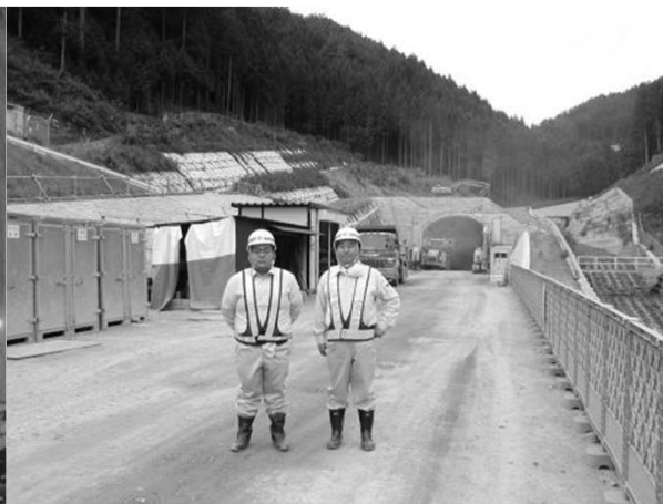
国道33号線 三坂第一T(愛媛) 工事現場見学
