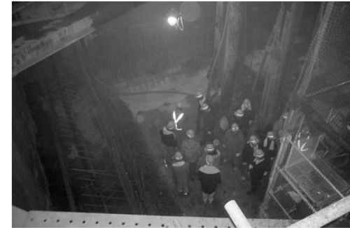
東京メトロ副都心線 工事現場見学
