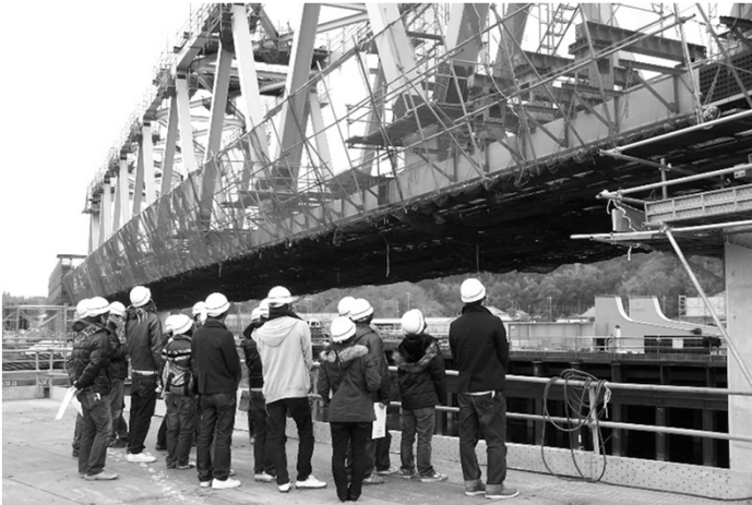
スカイアクセス線工事見学
