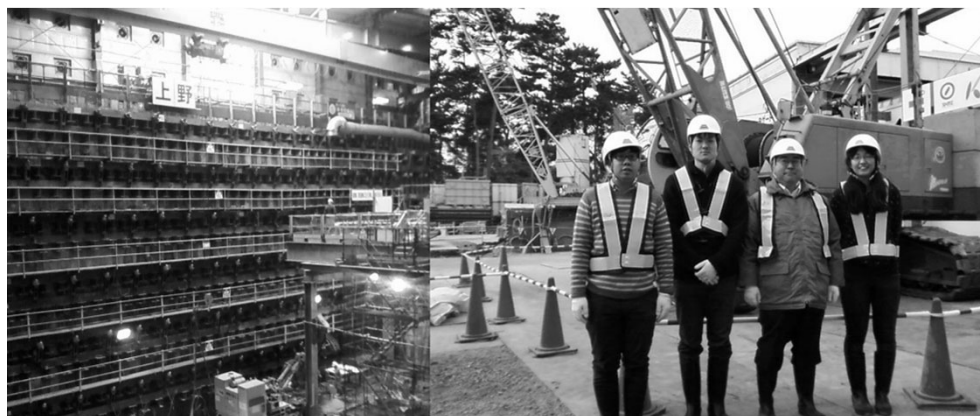
外環自動車道トンネル工事現場見学
