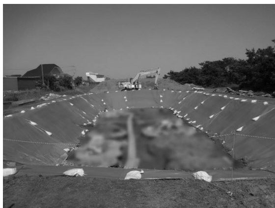
飯岡研修センター跡地で大規模実験を実施
