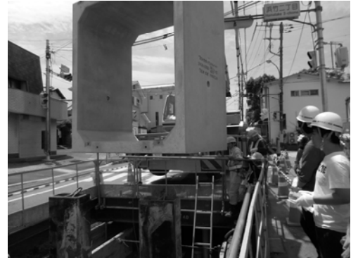
オープンシールド工事見学(茅ヶ崎)
